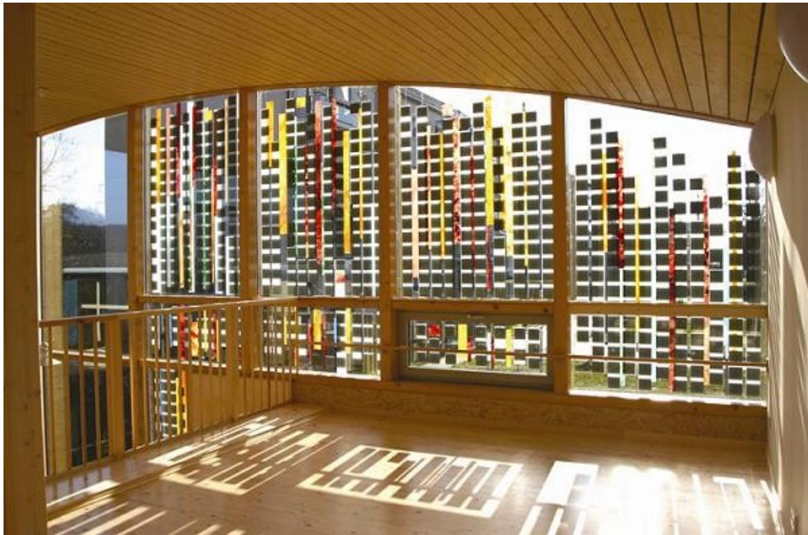
Das Hauptaugenmerk des Hauses, was die Energietechnik betrifft, fällt aber sicher immer auf die fassadenintegrierte Photovoltaikanlage. Sie leistet 1,1 kWp unter Standardbedingungen. Gleichzeitig ist sie ein künstlerisch gestaltetes Fenster. Hier wurde solare Energiegewinnung mit anspruchsvoller Glasgestaltung zusammengeführt. Kunst am Bauwerk mit innovativer Technik, öffentlichkeitswirksam eingesetzt, ist das besondere Zeichen am Christlichen Kinderhaus.
