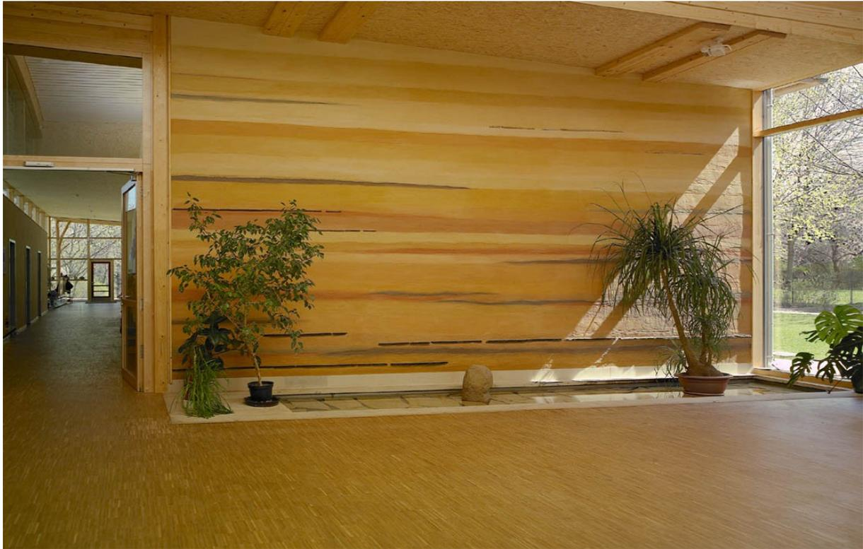
Die mit Lehmziegeln ausgefachten Fachwerkwände in den Gruppenräumen mauerten die Kinder und deren Eltern gemeinsam an nur fünf Wochenenden aus. Auf diese Innenwände wurde Schilfrohr aufgenagelt und eine Wandflächenheizung mit Kapillarrohr montiert. Alles zusammen ist mit Lehm überputzt, mit Kaseinfarben gestrichen und mit Naturfarben lasiert. So entstanden sehr diffusionsoffene Wände, die Feuchtigkeit und Wärme gut speichern können und somit ein angenehmes Raumklima schaffen.
