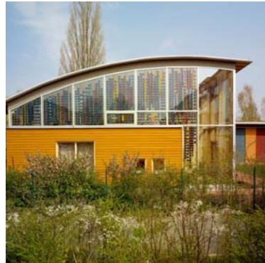
Kindergarten Dresden, Ulmenstraße
