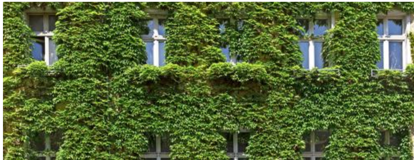
Wirkungsvoll: Begrünte Hausfassaden sorgen dafür, dass es in den Gebäuden angenehm kühl bleibt.
