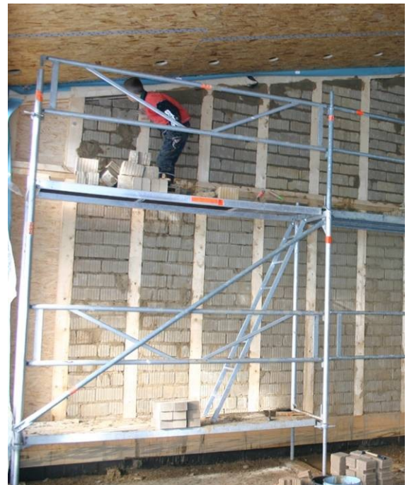
Lehmsteinausmauerung der Innenwände
