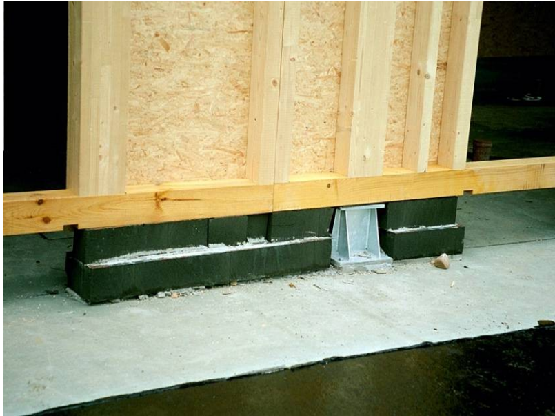
Holzrahmenbau auf Schaumglasschwelle
